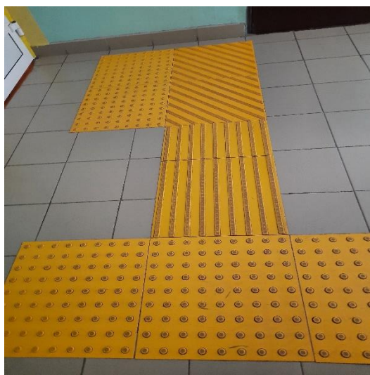
Тактильная плитка на полу на входе в здание, группу и в группе
